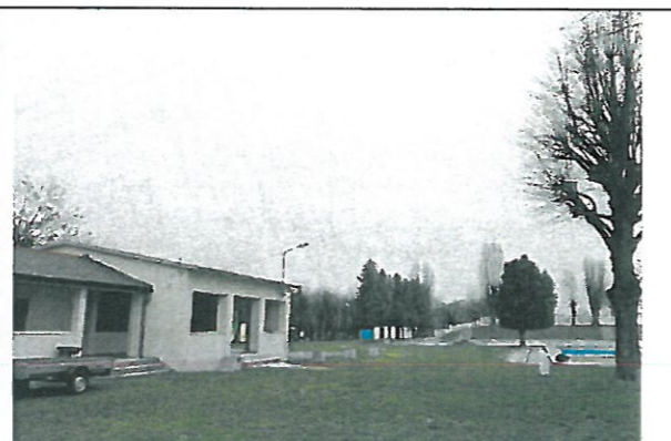
Fot.2. Nieużytkowane budynki.
