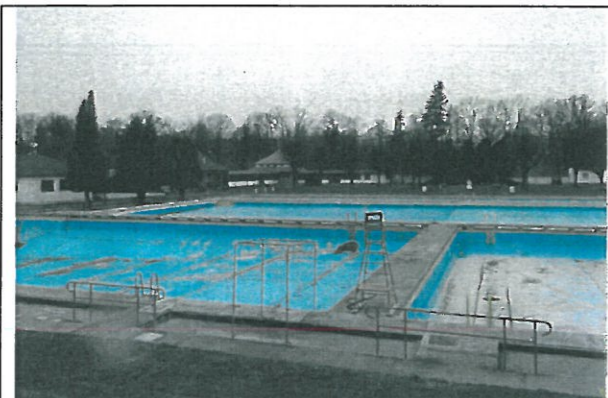
Fot.1. Widok na niecki basenów.
